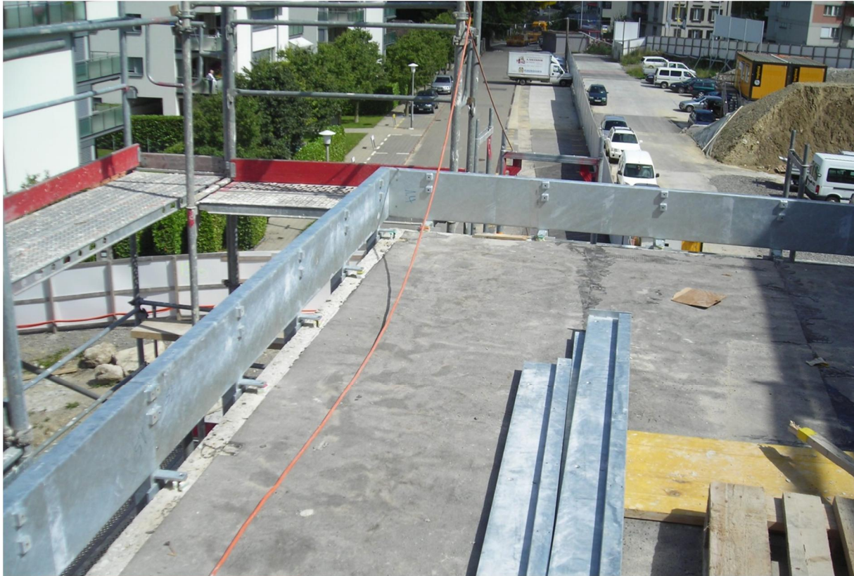
Abbildung 1: Geländerunterkonstruktion im Rohbau
