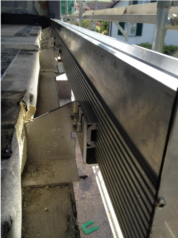
Abbildung 2: Unterkonstruktion für Glasgeländerhalteprofil
