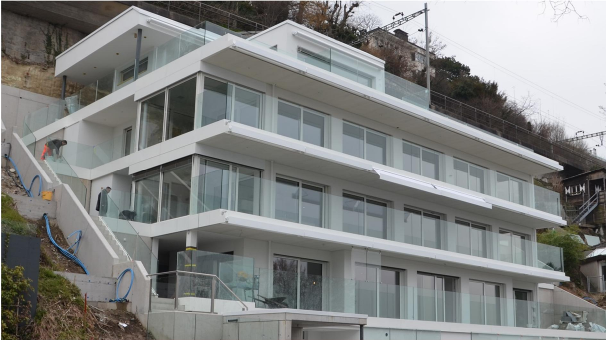
Abbildung 3: Fertig erstelltes Glasgeländer
